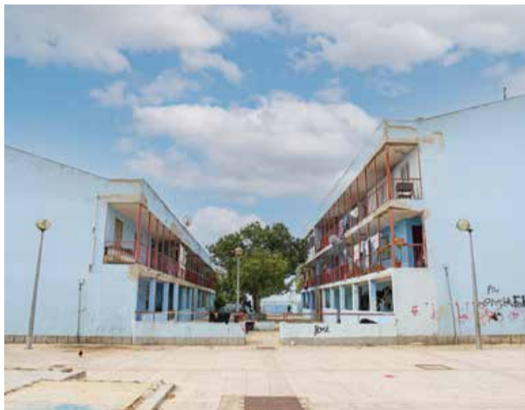
O Forte da Bela Vista também é reabilitado
