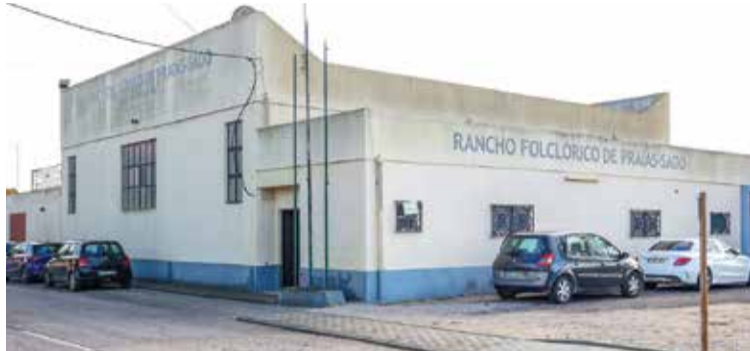
Instalações do Rancho Folclórico de Praias do Sado vão ser requalificadas
