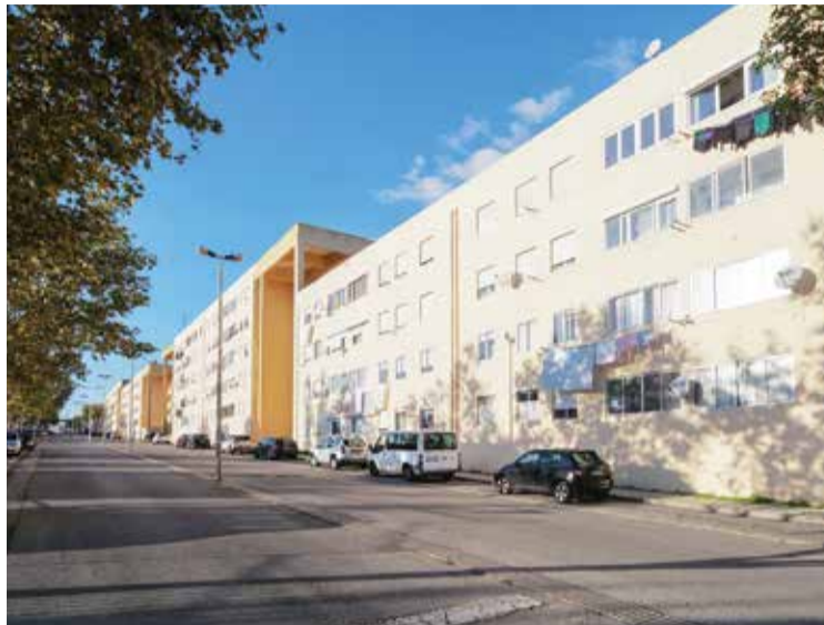
A obra no edifício da Bela Vista foi adjudicada
