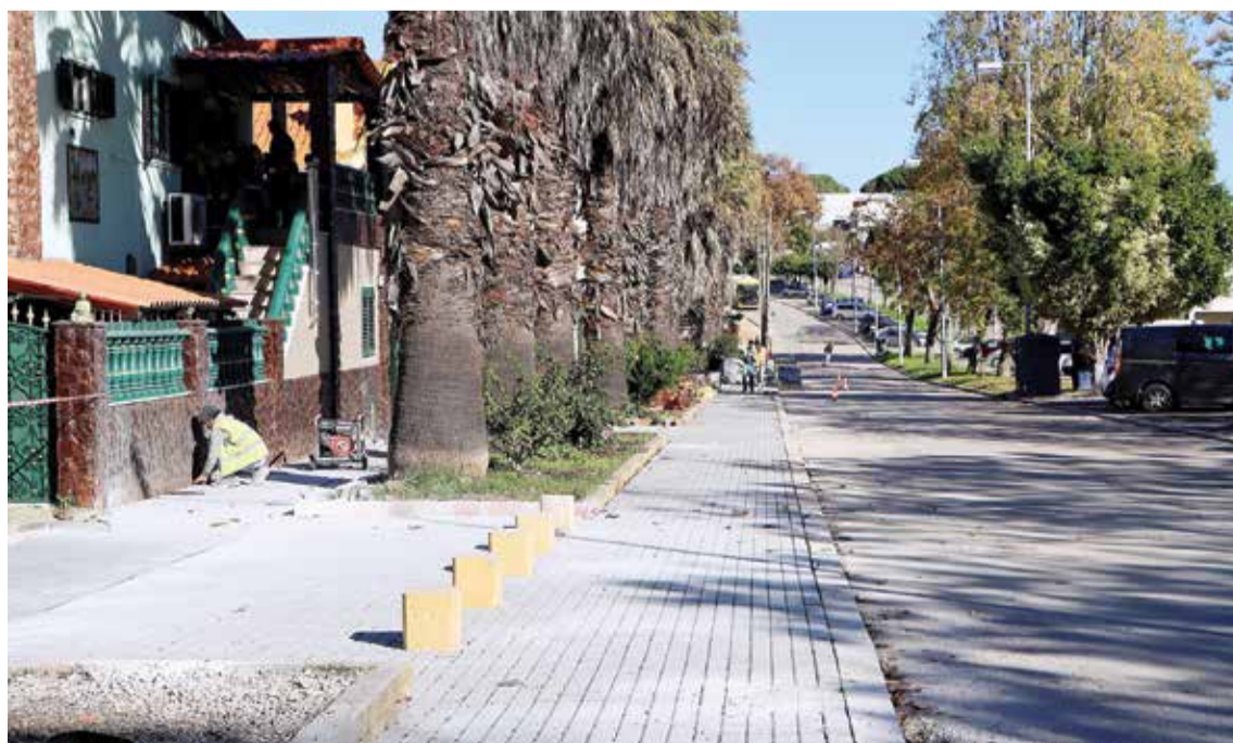
A operação está em curso na Avenida Soeiro Pereira Gomes
