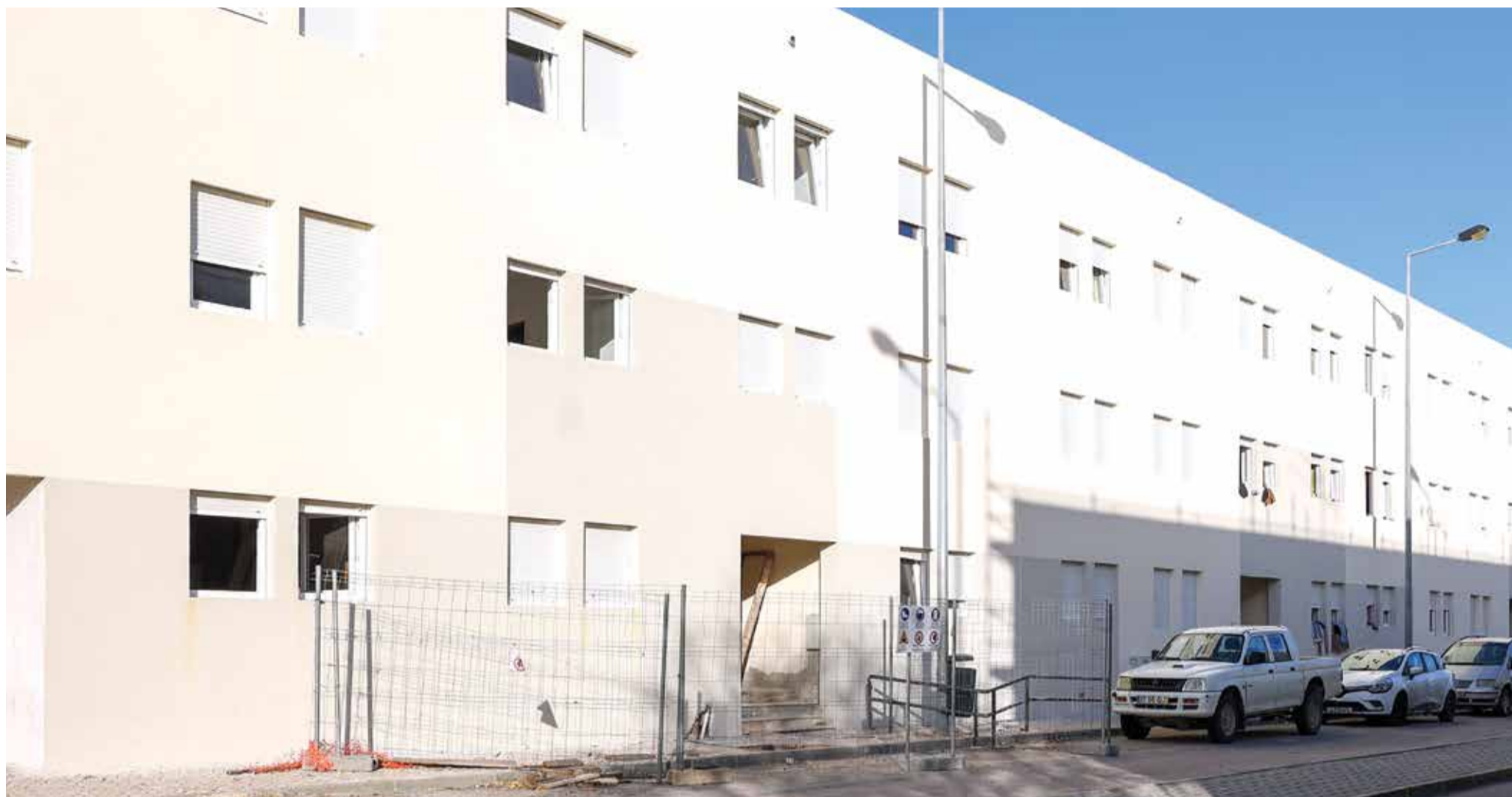
Dois dos dezanove edifícios do Bairro das Manteigadas já foram requalificados por dentro e por fora nesta que é a primeira ação de reabilitação de habitação pública ao abrigo do PRR
