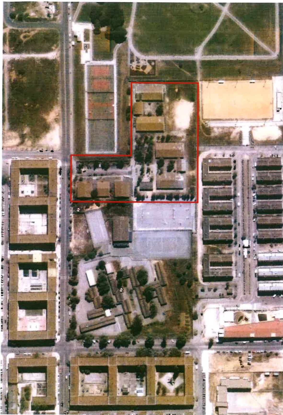
Imagem Google 2004 – Escola Ana de Castro Osório (desativada)
