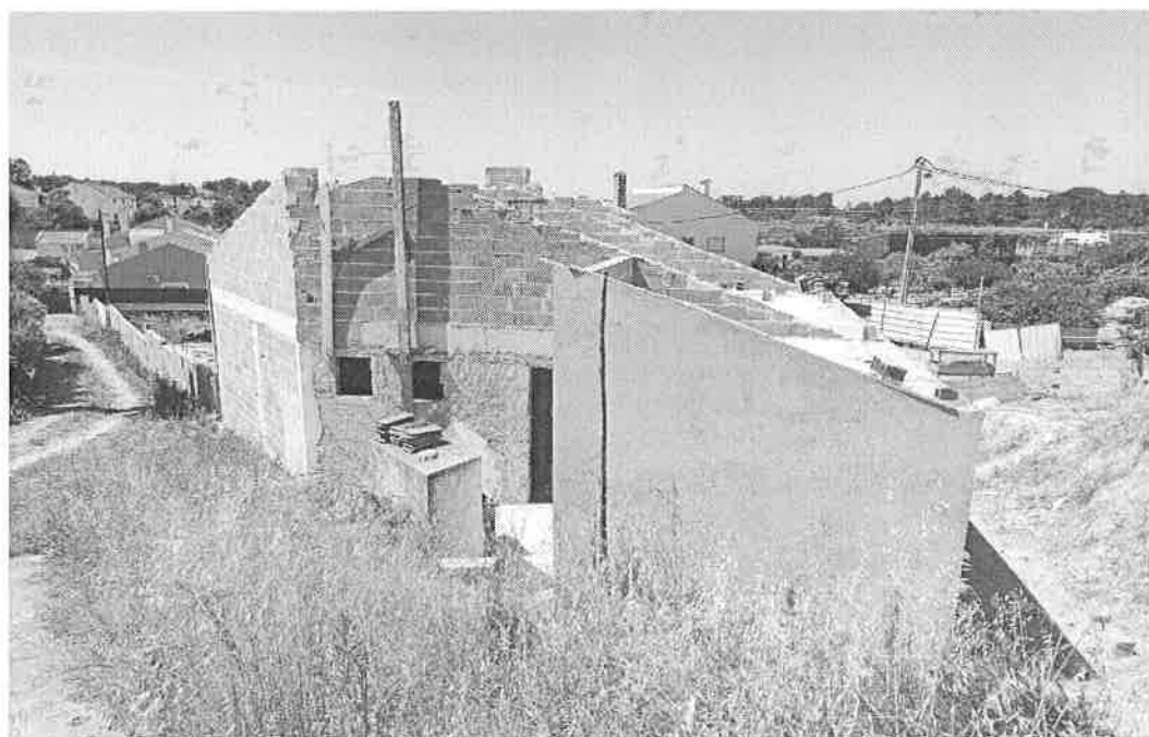
Foto 1 - Cobertura, alçado posterior
