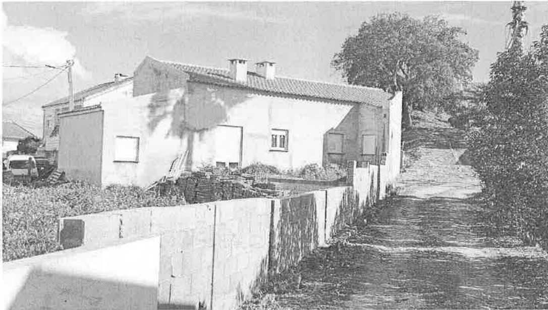
Foto 6 – Muro de delimitação e alçado lateral
