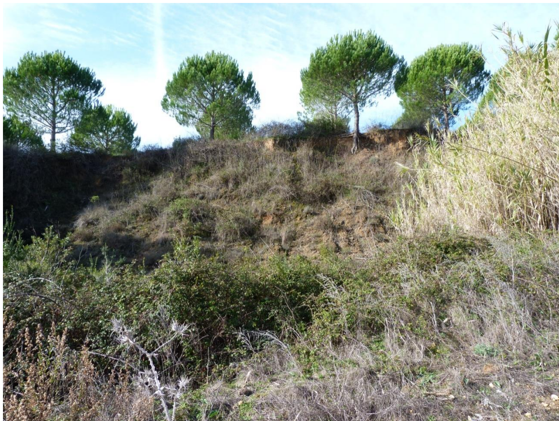
Figura 25 - Deslizamento rotacional na área de Picheleiros, em terrenos predominantemente margosos de idade paleogénica.
