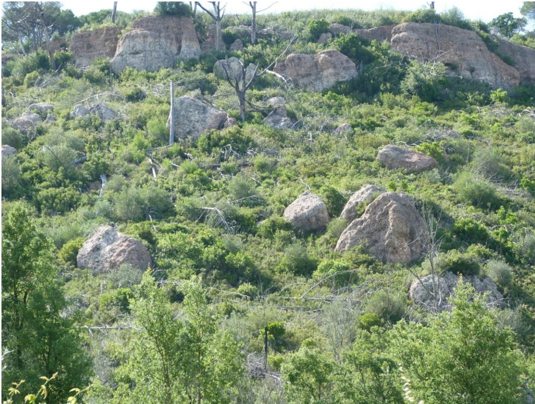
Figura 4.15 - Blocos desabados junto à Estrada R-379-1, a SW da Aldeia da Piedade.
