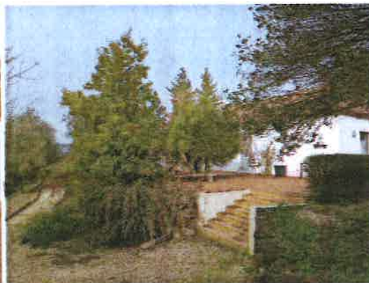
Foto 4 – Acesso ao alçado oeste
