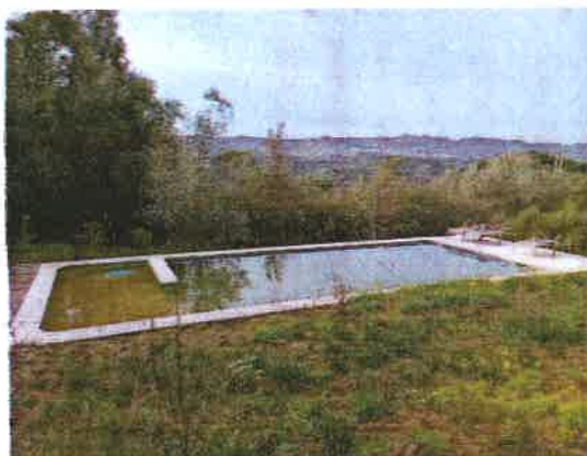
Foto 5 – Piscina localizada a oeste da construção principal
