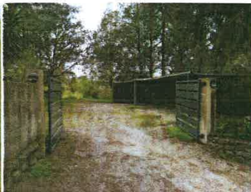
Foto 8 – Portão de acesso ao telheiro sombreador
