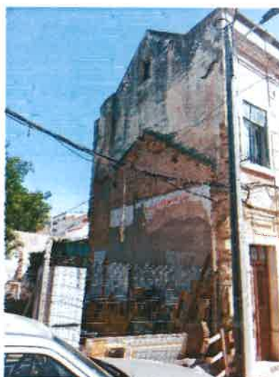
Foto nº 2 – Fachada lateral esquerda
