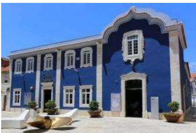
Figura 36 – Recolhimento da Soledade, Casa da Baía
