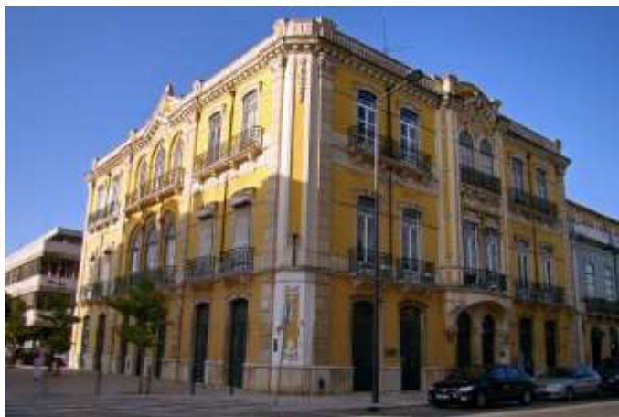
Figura 35 - Edifício do Club Setubalense
