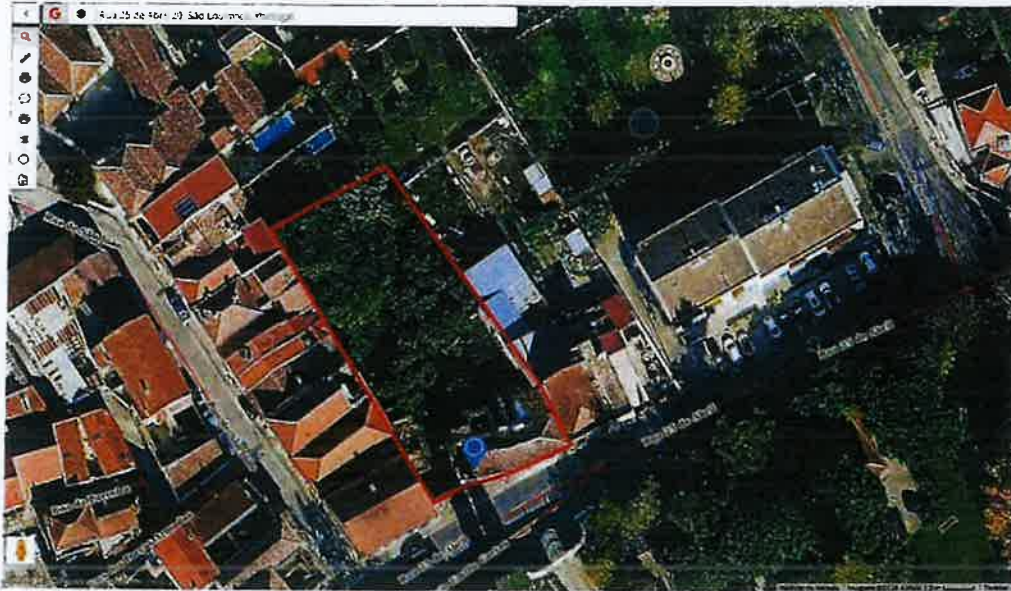
Imagem 01 – Imagem retirada do Geoportal (data da consulta 13/02/2025) – Localização do edificado e terreno em avançado estado de degradação localizado na Rua 25 de Abril n.º 20, Aldeia de Irmãos, União de Freguesias de Azeitão em Setúbal.
