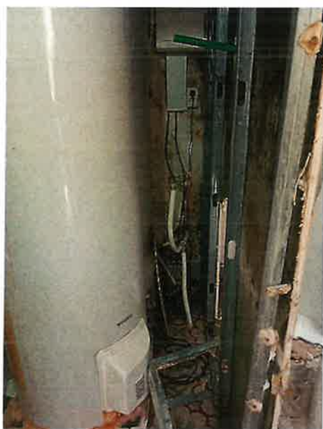
Fotos nºs 7 e 8 – Ligação dos termoacumuladores à rede elétrica
