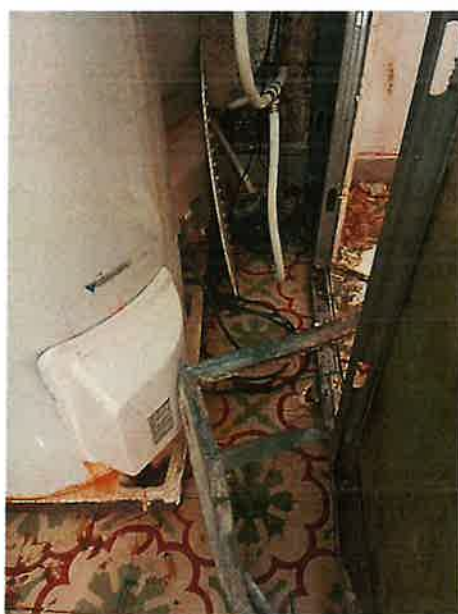
Fotos nºs 7 e 8 – Ligação dos termoacumuladores à rede elétrica
