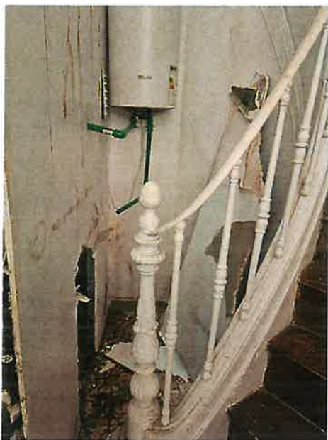
Foto nº5 – Escada de acesso ao 1º andar
